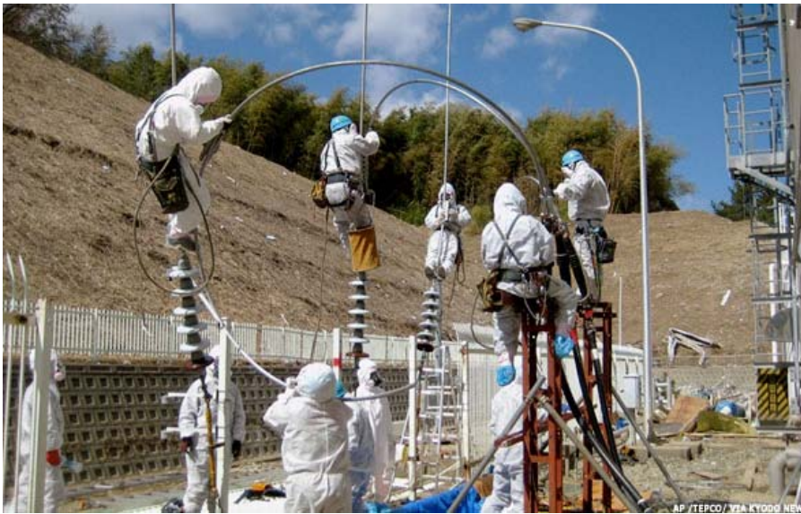
พนักงานติดตั้งสายไฟฟ้าแรงสูงจากแหล่งกำเนิดภายนอกเพื่อนำพลังงานมาใช้กับระบบทำความเย็นของเตาปฏิกรณ์
