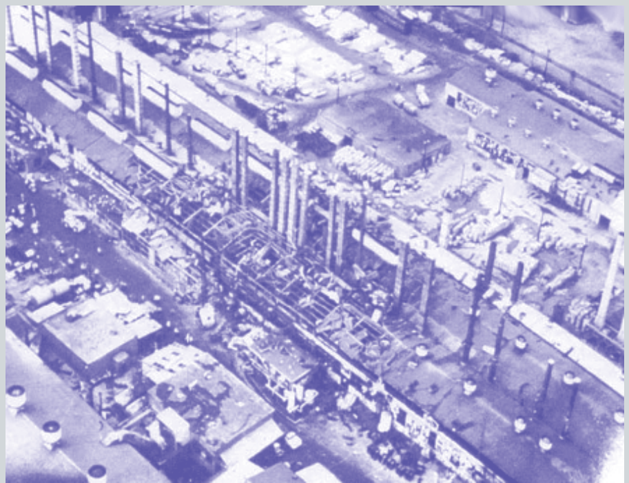
ภาพ A : ผลลัพธ์จากการระเบิดอย่างรุนแรงของโรงหลอมอะลูมิเนียม
